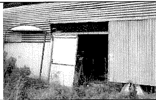
Corpo B - vista lato est
