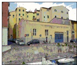
Autorimessa mezzi provinciali
