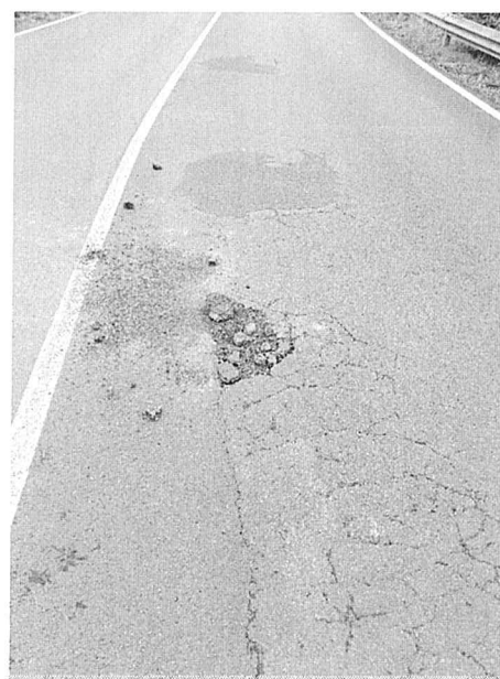
SP 24 "Bivio Boni – Procchio", rialzamento ed il distacco di piccole porzioni di asfalto
