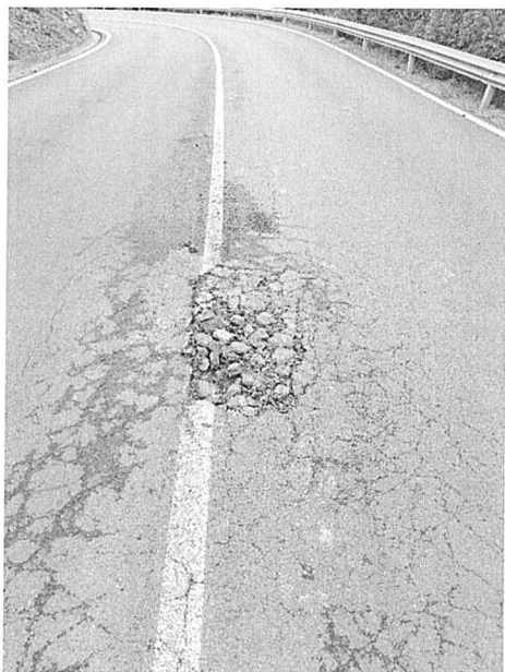
SP 24 "Bivio Boni – Procchio", rialzamento ed il distacco di piccole porzioni di asfalto
